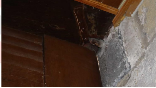
Fotoğraf 9. Mustafa Yıldırım, “Ökçe Demiri İçerisinde Hareket Eden Ahşap Mil Görünümü”, 2022i.
