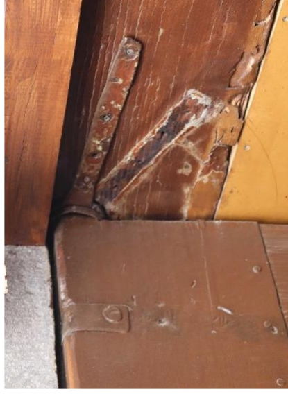
Fotoğraf 7. Mustafa Yıldırım, “Lento İçerisinde Hareket Eden Ahşap Milin Görünümü”, 2022ğ.
