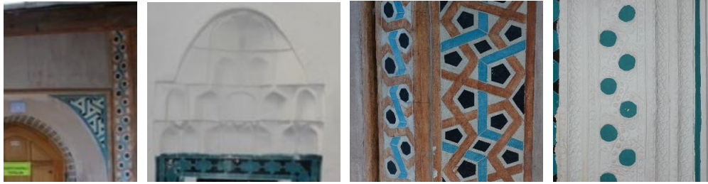
Resim 29: Mescit, kapı açıklığı, tamamlama (I. K. Arşivi).
