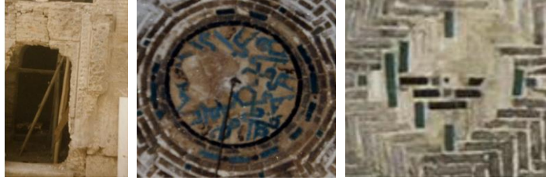
Resim 15: Mescit, kapı açıklığı, taşıyıcı sorunu (K.V.B.M.).
